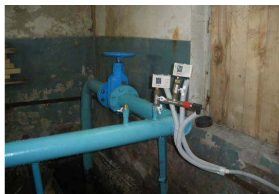
Рис. 24. Датчики давления (Залив Риеккаланлахти)
