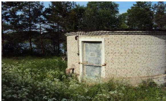
Рис.19. Береговой колодец РВЗ на берегу залива Хаменлахти
