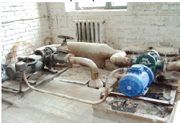
Рис.13. Воздуходувный агрегат для водо-воздушной промывки песчаных фильтров
