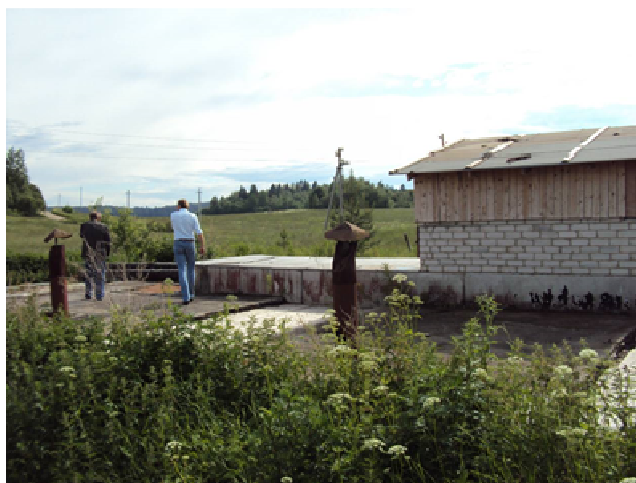
Рис. 10. Аэротенки с продленной аэрацией со встроенными горизонтальными вторичными отстойниками
