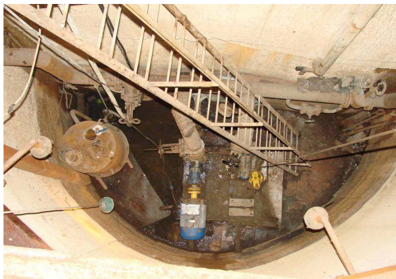
Рис. 9. Насосное отделение КНС № 1 с насосом марки СМ 80-50-200а/2
