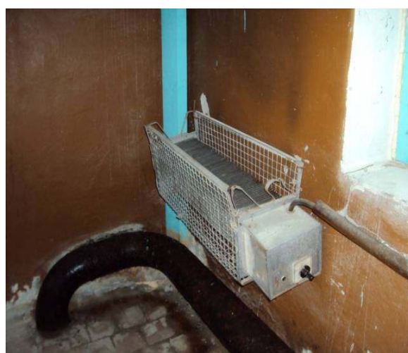
Рис. 6. Обогрев помещения в зимний период предусмотрен от электронагревателей
