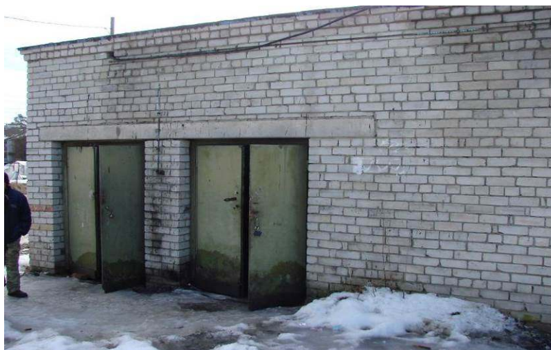
Рис. 8. Здание КНС № 1 в пос. Куркиеки
