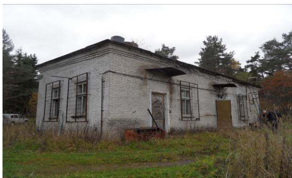
Рис. 21. Здание ВНС (Залив Хаменлахти)
