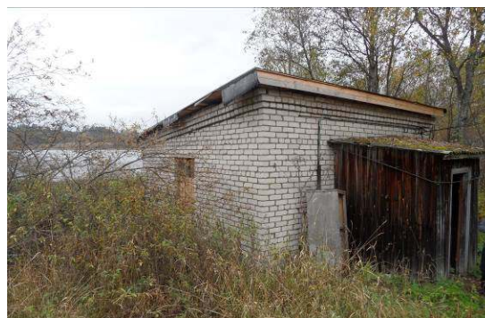
Рис. 22. Здание ВНС (Залив Риеккаланлахти)
