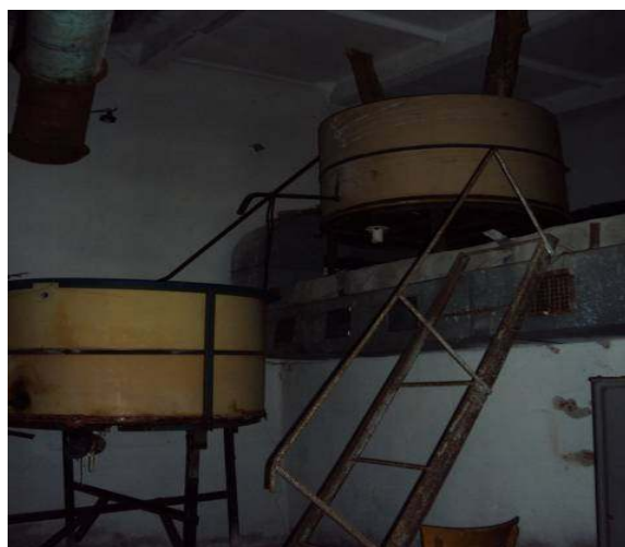
Рис. 5. Емкости для приготовления рабочего раствора хлорной извести
