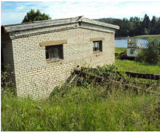
Рис. 27. Здание КОС пос. Ласанен
