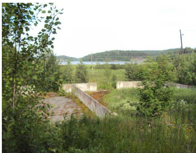
Рис. 11. Иловые площадки для обезвоживания избыточного ила
