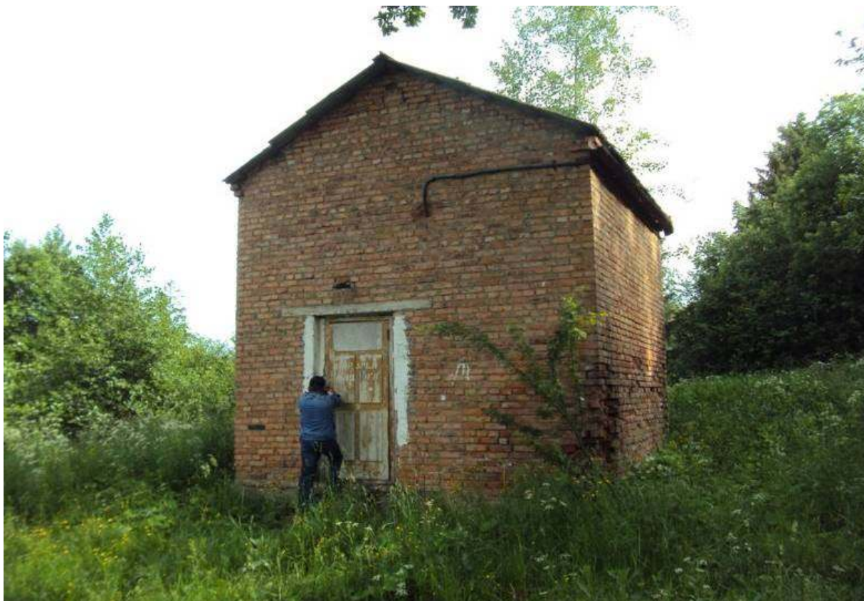
Рис.7. Здание водопроводной насосной станции п. Куркиеки, резервного источника водоснабжения – залива Куркиекский
