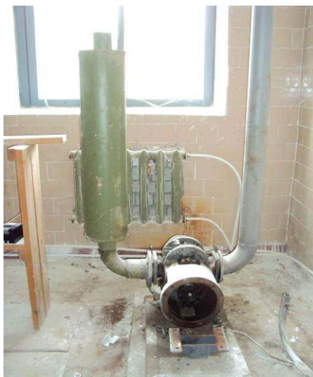
Рис.13. Воздуходувный агрегат для водо-воздушной промывки песчаных фильтров
